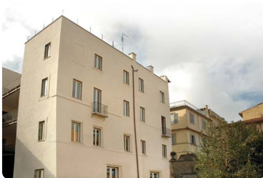
La facciata sul cortile interno dello stabile
